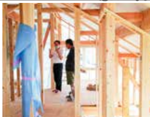
断熱材の施工前は、柱や金物、筋交いなど、どんな材料をどのように施工しているか全て確認できます
