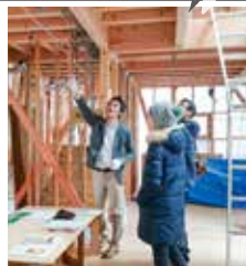
断熱材の施工前は、柱や金物、筋交いなど、どんな材料をどのように施工しているか全て確認できます
